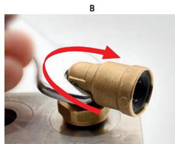
3. Установить фитинг в необходимое конечное положение, поворачивая его на угол до 180° по часовой стрелке или против часовой стрелки
